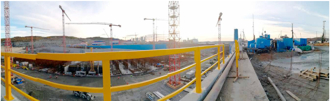
Großbaustelle, auf der Muehlhan Isolierungsarbeiten durchführt
