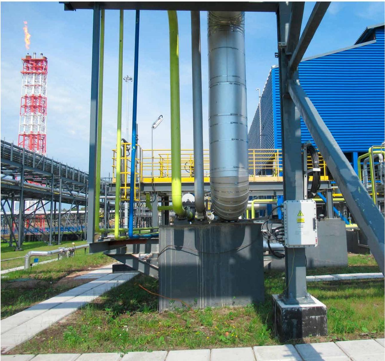
Isolierungsarbeiten an einer Gasförderanlage
