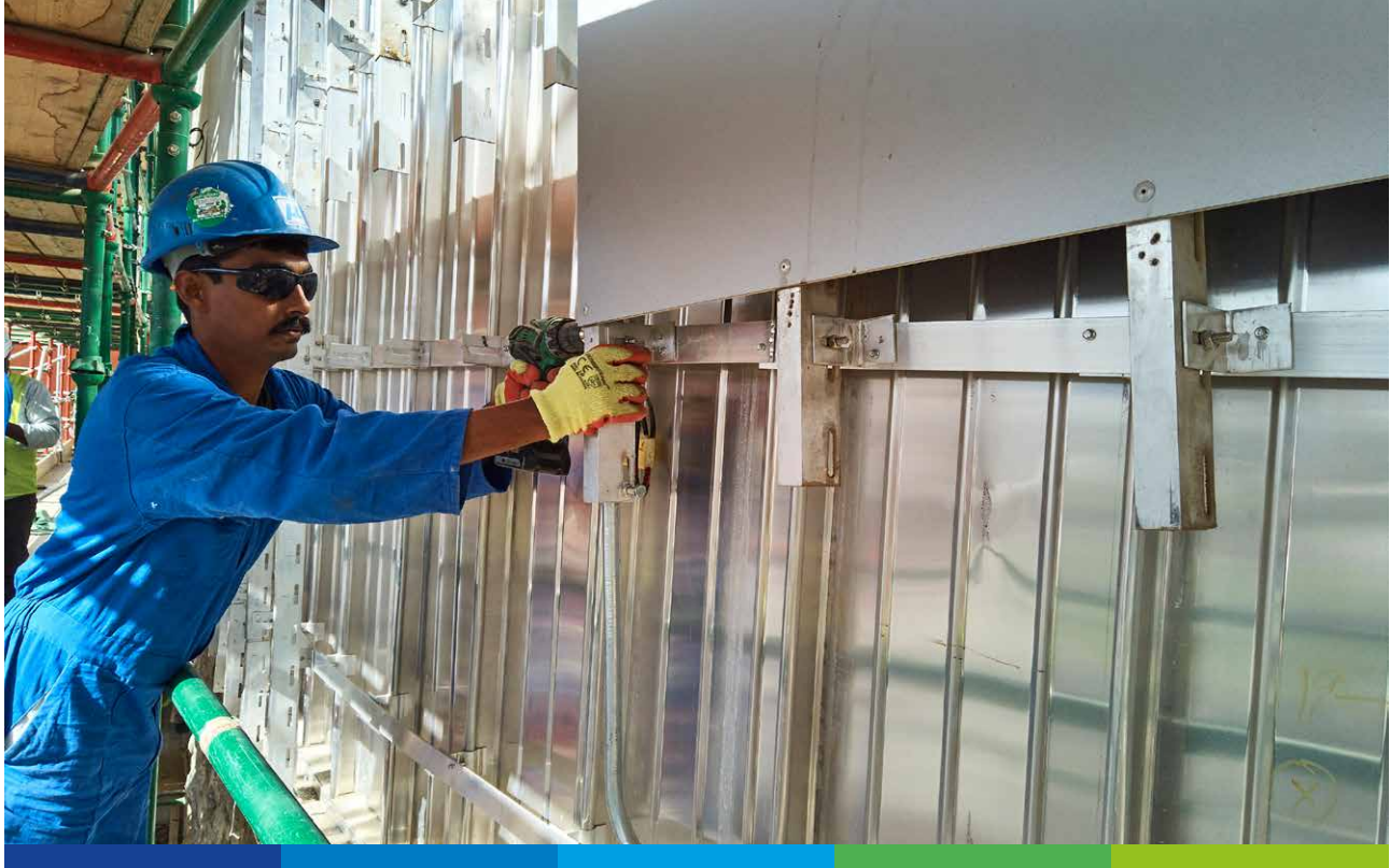
Anbringen von passivem Brandschutz
